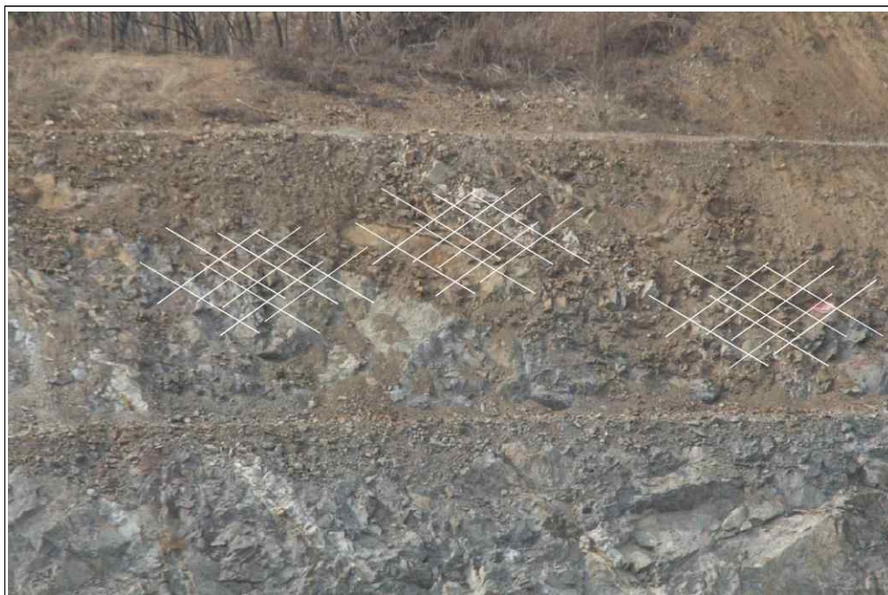
【그림 36】 D 영역 상세사진 (세편화된 암석)
