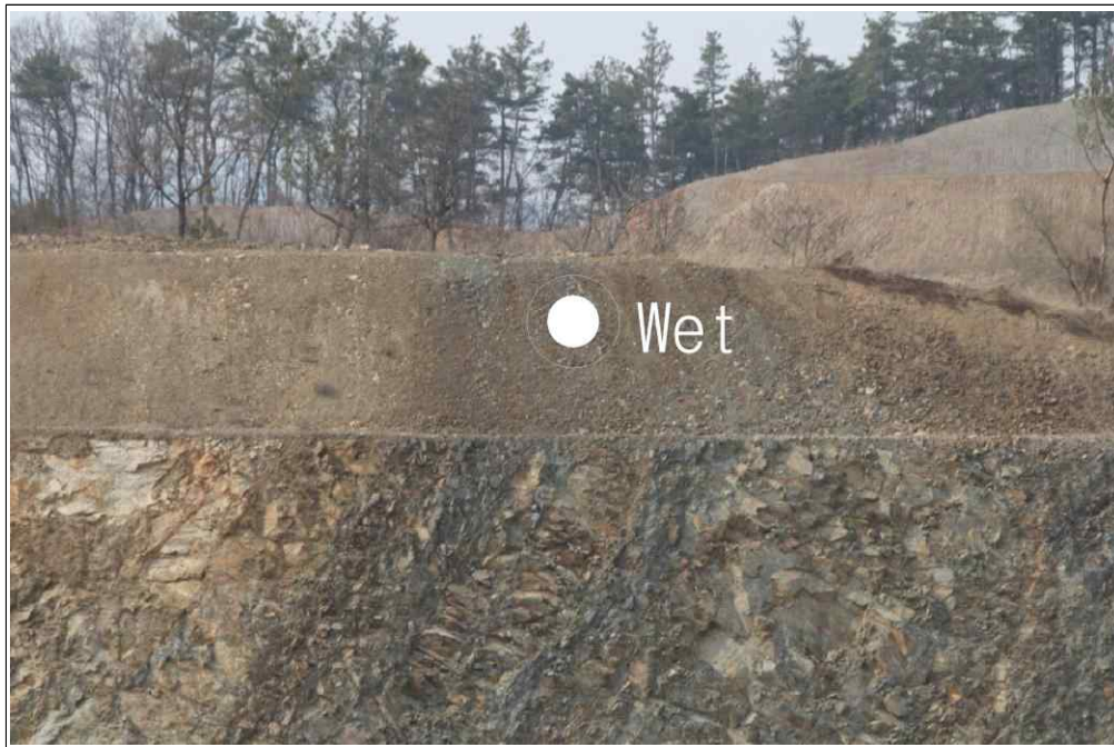
【그림 25】 B 영역 상세사진 (지하수 유출)
