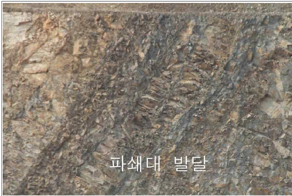
【그림 23】 B 영역 상세사진 (파쇄대 발달)
