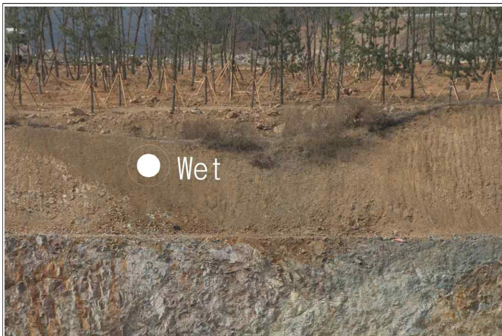
【그림 15】 A 영역 상세사진 (지하수 유출)
