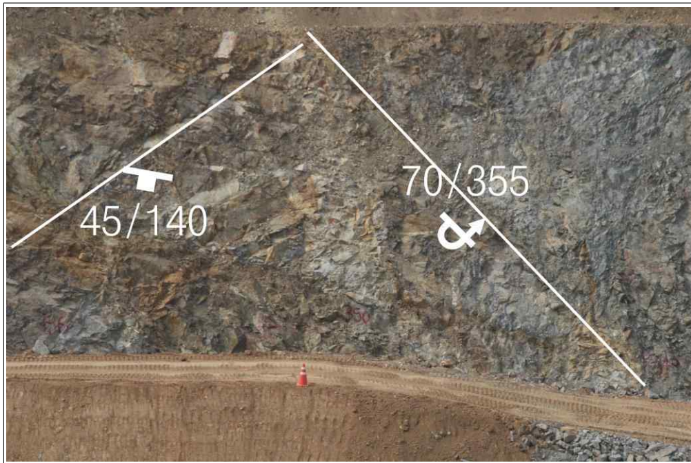
【그림 28】 C 영역에 발달한 불연속면
