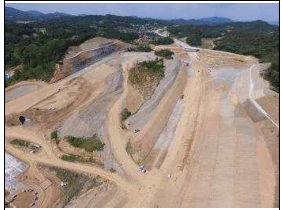
【그림 4】 깎기비탈면 종점부 측면 사진
