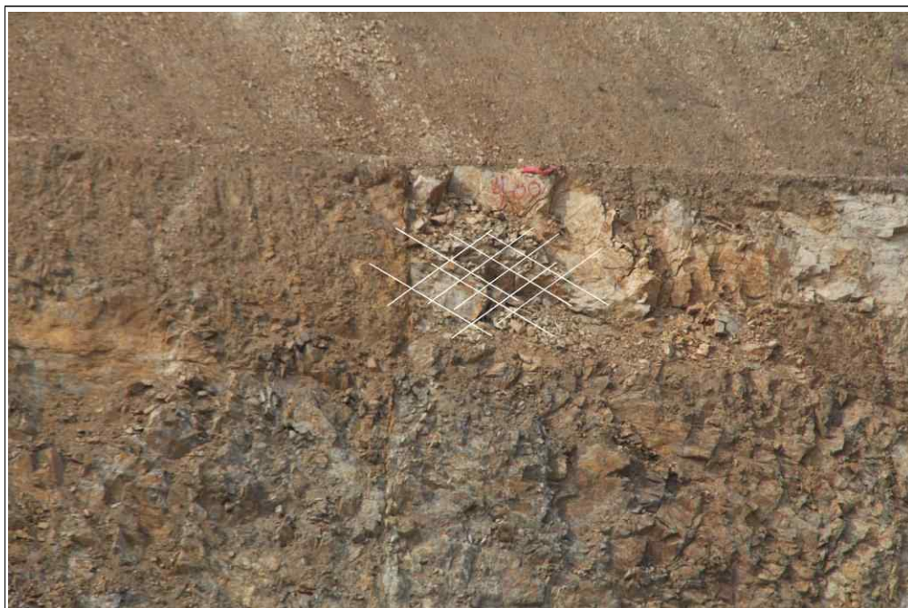
【그림 24】 B 영역 상세사진 (세편화된 암석)
