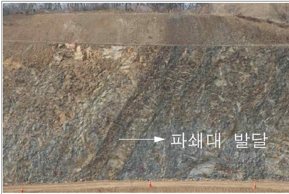
【그림 21】 B 영역 상세사진 (파쇄대 발달)
