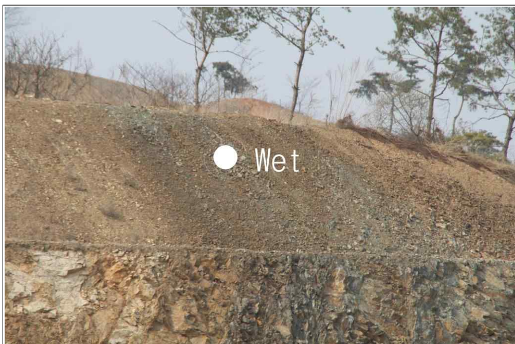
【그림 26】 B 영역 상세사진 (지하수 유출)
