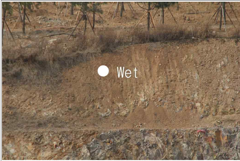
【그림 16】 A 영역 상세사진 (지하수 유출)
