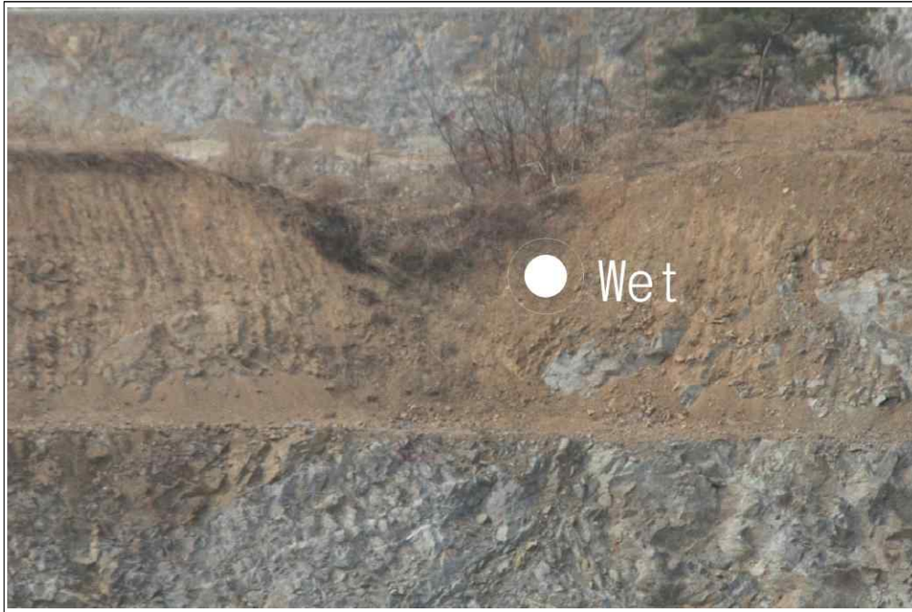
【그림 30】 C 영역 상세사진 (지하수 유출)
