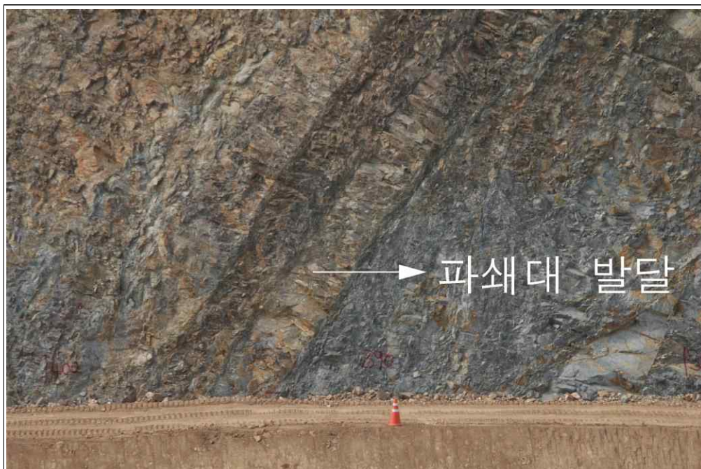
【그림 22】 B 영역 상세사진 (파쇄대 발달)
